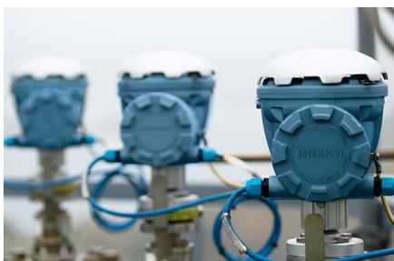
Надежность является критическим фактором для эксплуатации систем хранения охлажденных сред. Для измерения уровня жидкости в таких системах обычно реализован принцип «2 из 3» с тройным резервированием
