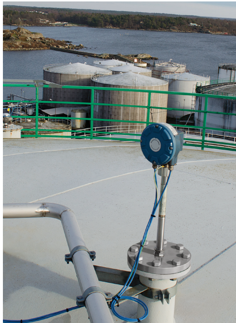
Рис. 6.1. Верхний преобразователь температуры, состоящий из 16 датчиков.
