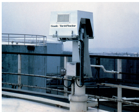
Рис. 2.9. Первый высокоточный радарный уровнемер был установлен на резервуаре нефтеперерабатывающего завода в 1985 году.
