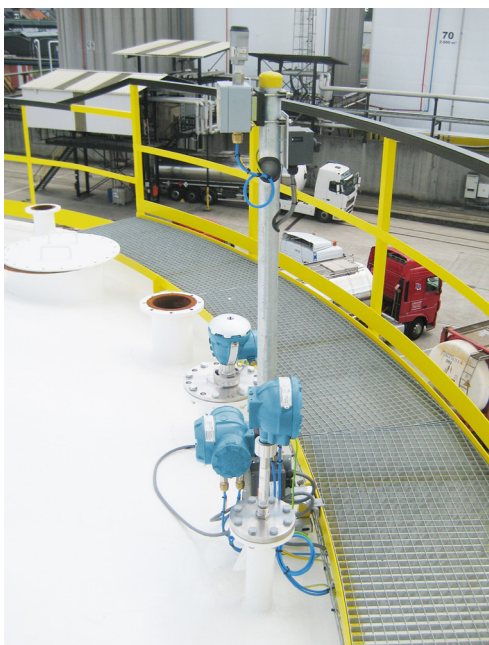
Рис. 9.8. Антенна, подключенная к устройствам резервуара.
