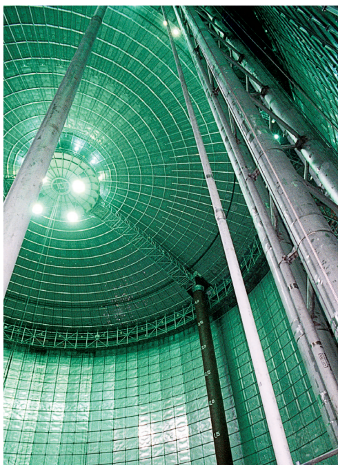
Рис. 7.4. Двухоболочечные резервуары закрытого типа, используемые для охлажденного сжиженного газа.
