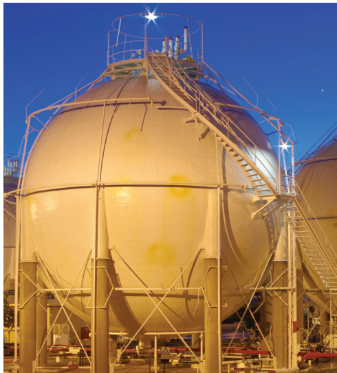
Рис. 3.5. В резервуарах высокого давления выполнение ручного измерения уровня невозможно, что приводит к конкретным требованиям использовать сервоуровнемеры и радарные уровнемеры.
