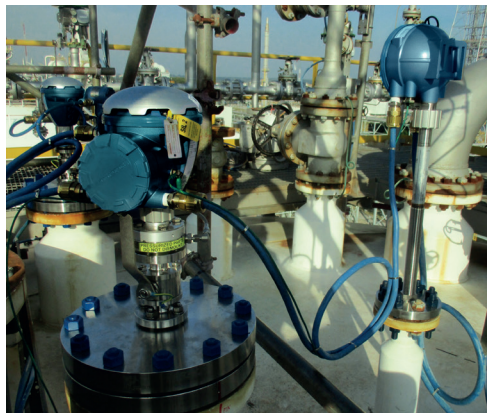
Рис. 9.3. Резервирование получения данных резервуара производится при помощи двух уровнемеров и отдельных каналов связи: проводного и беспроводного.
