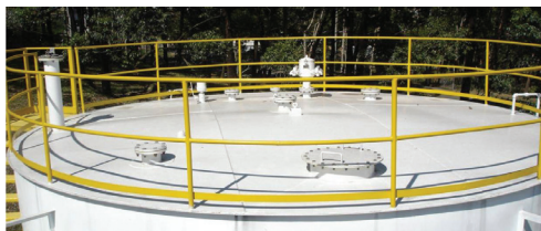
Рис. 2.14. Отверстия в неподвижной крыше резервуара.
