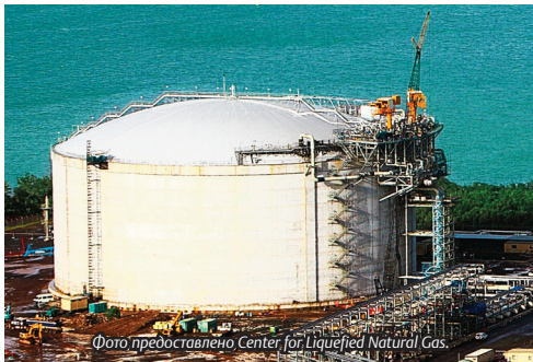
1.4. Криогенный резервуар, хранящий СПГ при -162^{\circ}\text{C} .
