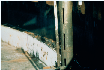
Рис. 2.16. Режим малых потерь может использоваться для почти полного исключения деградации измерений в старых успокоительных трубах.
