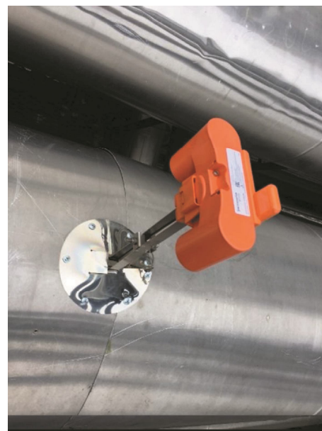
Рис. 1. Датчик смонтирован под изоляцией
