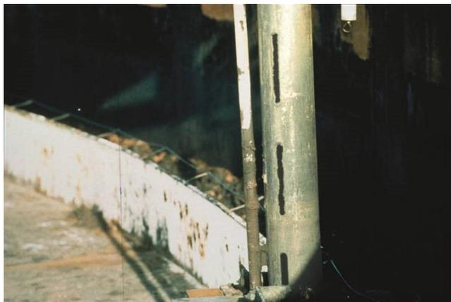
LPG 用途で最高の測定性能を発揮させるため、一体型圧力センサによって蒸気の影響を補正できます。LNG を含む液化ガスの密閉タンク内の測定は、アンテナとの距離が既知の恒久的に設置された検証ピンを使用して検証することができます。
