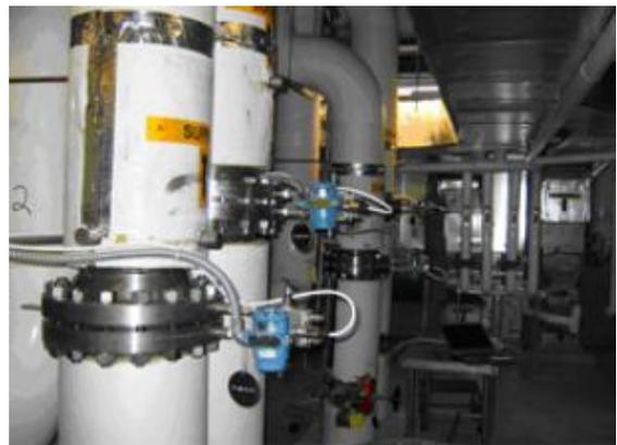
그림1. 컨디셔닝 오리피스 질량유량계 (1595 컨디셔닝 오리피스 플레이트와 3095 Multivariable 트랜스미터)
