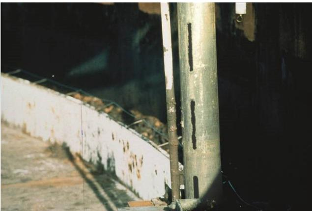
LPG 응용 분야에서 최고의 측정 성능을 위해 통합 압력 센서로 증기 영향을 보정할 수 있습니다. LNG를 포함한 액화 가스가 있는 밀폐형 탱크에서의 측정은 안테나까지의 알려진 거리를 가진 영구 설치 검증 핀을 사용하여 검증할 수 있습니다.
