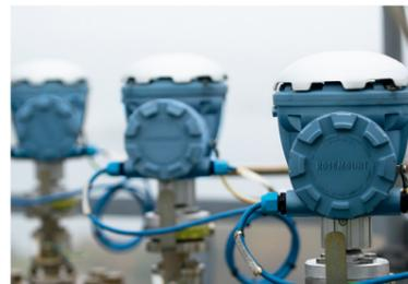
La fiabilité est essentielle dans le cadre des applications de stockage réfrigéré. Le système de vote deux sur trois (2oo3 voting) avec triple redondance est une solution habituelle pour les mesures de niveau.
