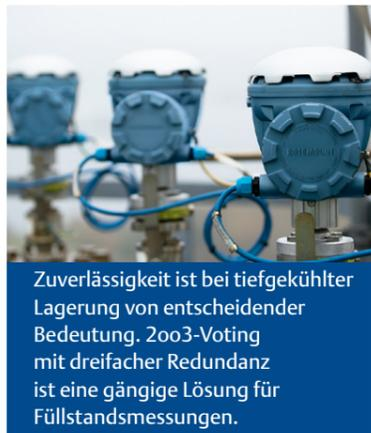
Zuverlässigkeit ist bei tiefgekühlter Lagerung von entscheidender Bedeutung. 2oo3-Voting mit dreifacher Redundanz ist eine gängige Lösung für Füllstandsmessungen.
