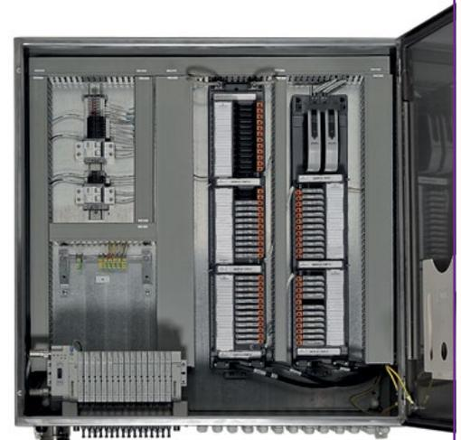
I/O su richiesta mediante il nodo CHARMs per ridurre la complessità del sistema, rispettando i tempi stabiliti per il progetto. ► p13
