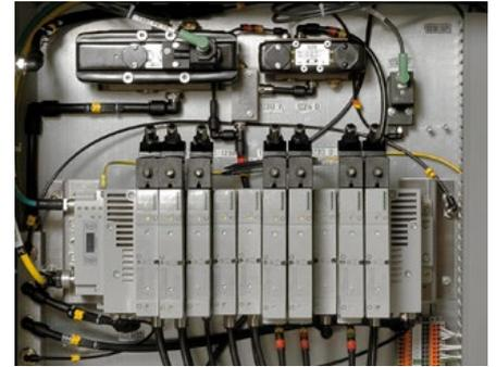
L'integrazione di più tipi di prodotti di processo riduce l'ingombro dell'installazione.
