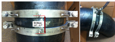
Figura 3-2: Distancia entre abrazaderas
