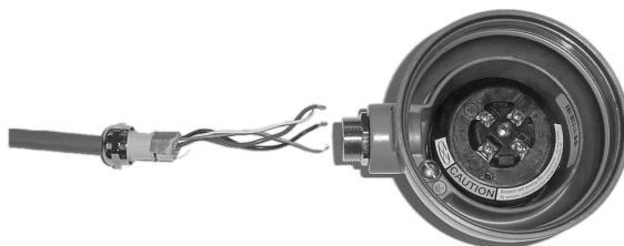
Rysunek 3-9: Instalacja korpusu dławika
