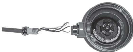
Figura 3-9: Instalando o corpo da selagem
