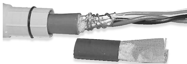
Figur 3-5: Aflederkabelkappen viklet to gange rundt om den blotlagte afskærmningsfolie
