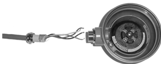
Figura 3-8: Installazione del corpo del pressacavo
