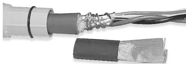
Figura 3-5: Fili di drenaggio schermati avvolti due volte intorno alla schermatura in alluminio esposta
