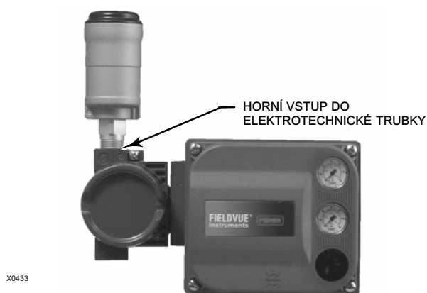
Obrázek 26. Adaptér THUM instalovaný na digitální korektor ventilu DVC6200
