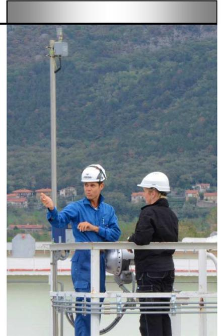
Il misuratore TankRadar Rex di Emerson è connesso al network Smart Wireless mediante l'antenna THUM, montata sulla palina posta in verticale sopra il serbatoio.
