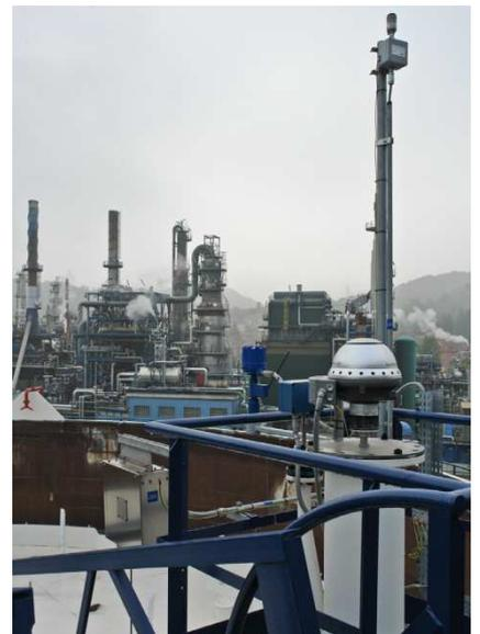
Misuratore TankRadar Rex dotato di adattatore THUM Smart Wireless.
